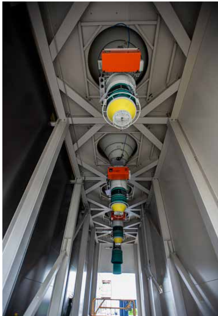
Smidigt och modernt distributionssystem för gjutsand. Cirka 70% av sanden kommer att kunna återanvändas.
