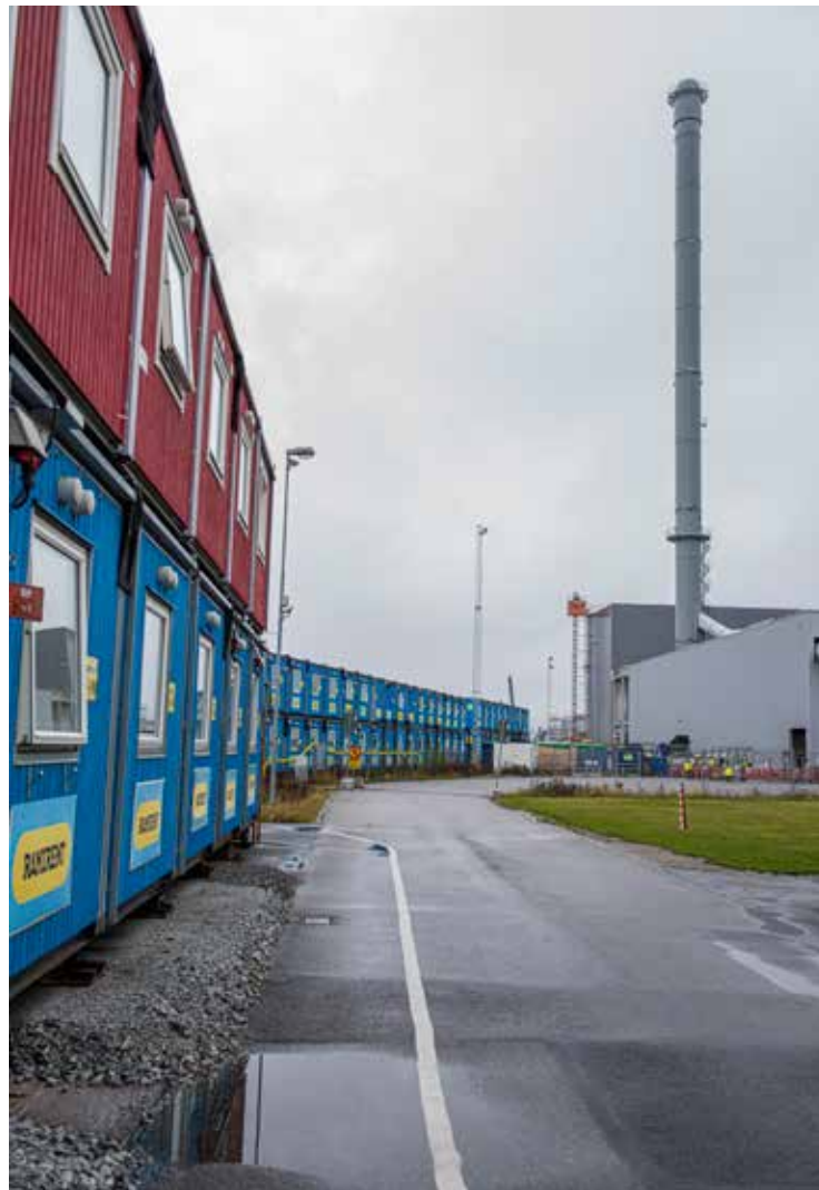
De tillfälliga arbetsplatserna och byggbodar med det nya gjuteriets skorsten i bakgrunden.
