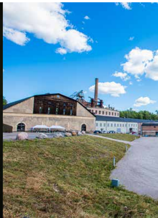
"Gropen" där gjuteriet en gång låg.
