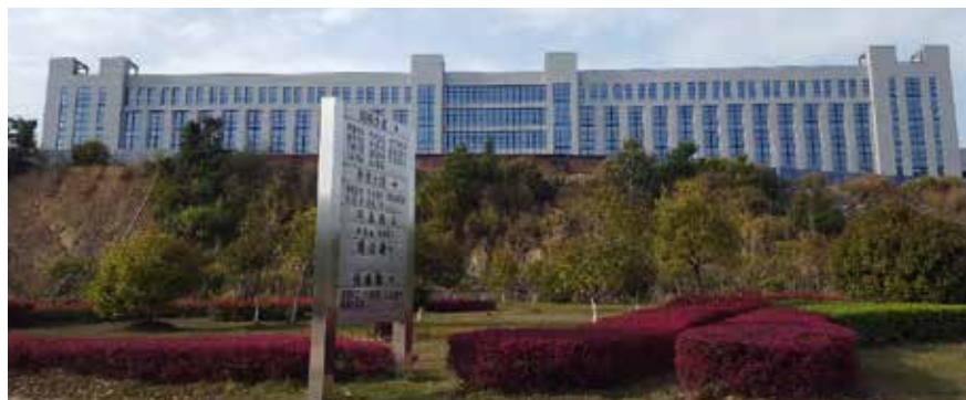
Första kontorshuset i den pågående satsningen på reogjutning i staden Jiangle i Kina. Bakom denna byggs nu ett stort antal fabrikslokaler om 3000 kvm styck för de som önskar etablera verksamhet relaterat till reogjutning.
